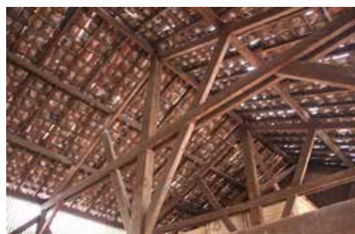
1. Houten spant Hergebruik van balk t.b.v bank
