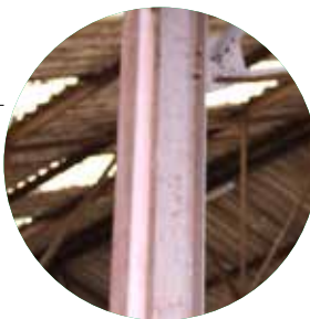
samengesteld profiel 220x200mm + 90x105 mm
