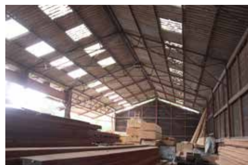
3. Stalen vakwerkspant (geen hergebruik)
