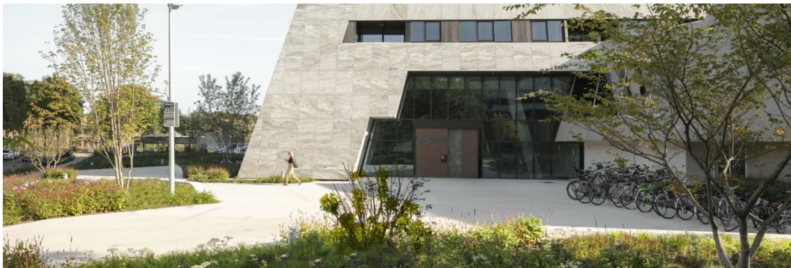
Foto bunkertoren overgang park en plein naar Urban 'Rauw & Puur'
