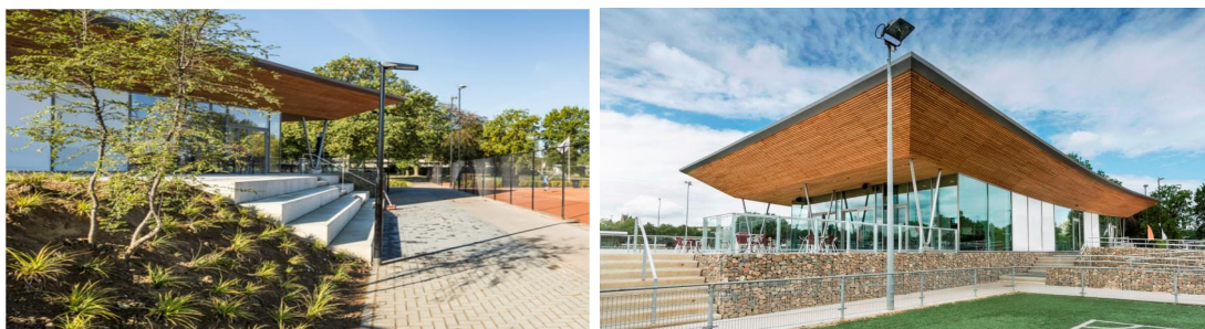
Voorbeeld van geïntegreerde tribune in plint van het gebouw op sportlandgoed de Haamen gemeente Beek, gebouw Van Pelt Architecten, terrein Kragten, bron: Kragten
